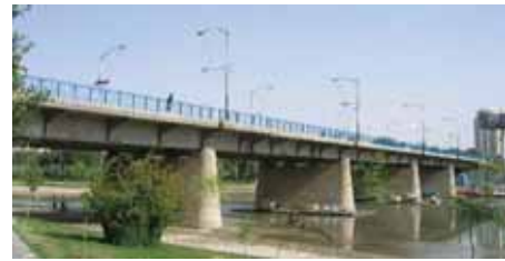
الف. نمای شرقی پل
