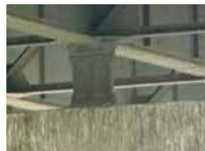
شکل (۵): تکیه‌گاه‌های پل فلزی؛ سمت راست تکیه‌گاه نوع ۱، سمت چپ تکیه‌گاه نوع ۲.
