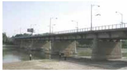
ب. نمای غربی پل
