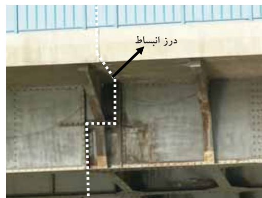
شکل (۳): شکل و ابعاد درزهای انبساط "تعدالی" در دهانه‌های میانی (ابعاد به سانتیمتر)
